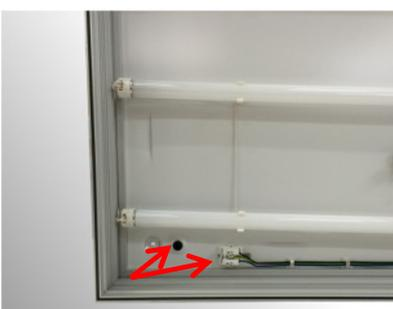
Der elektrische Anschluss erfolgt über die vorbereitete Kabelführung und die Anschlussklemme.
